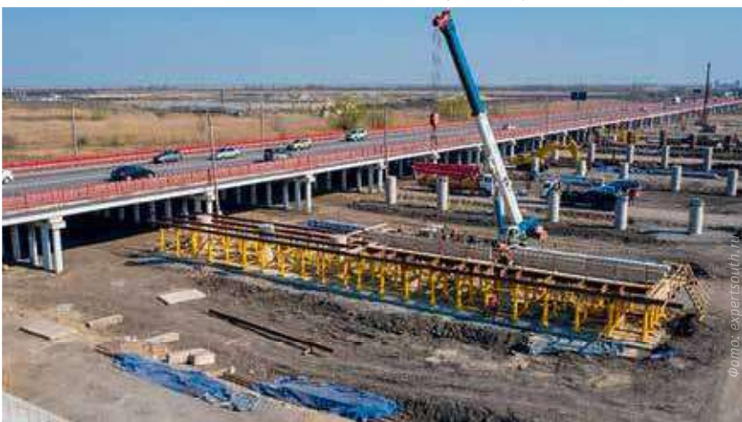
Строительные работы в Ростовской области
